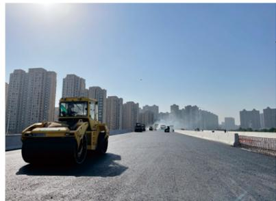
在施工现场，施工人员和相关机械、车辆正在紧张有序地摊铺作业。伴随着机器的轰鸣声，滚热的沥青混凝土从物料车上泻下，平整地摊铺到路面，腾起阵阵热浪。现场施工人员紧张有序忙碌着，人员的指挥声和施工机械的轰鸣声交织在一起，形成一首繁忙、热闹的施工“交响曲”。
