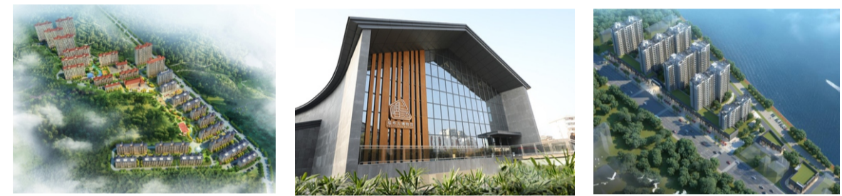
定南县易地搬迁扶贫县城集中安置点建设项目
